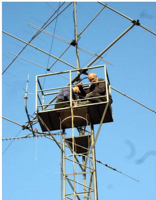
Matteo IZ1KGK e Roberto IK1RDJ in cima al traliccio della Sezione per fissare una antenna inverted-L per i 160 m prima del contest CQWW SSB 2006.
