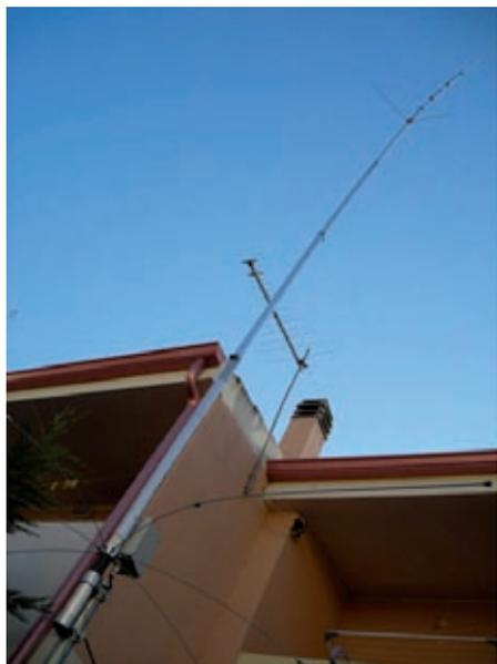
di facile montaggio e manutenzione, l'antenna di Giovanni non ha bisogno di accordatore, l'ho installata a due metri da terra su di un basamento per ombrelloni da spiaggia, la sua altezza risultante è di circa nove metri, opportunamente controventata per salvarla dalle raffiche di maestrale piuttosto frequenti.
