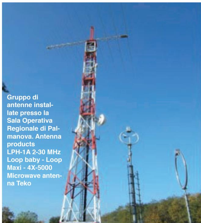
Gruppo di antenne installate presso la Sala Operativa Regionale di Palmanova. Antenna products LPH-1A 2-30 MHz Loop baby - Loop Maxi - 4X-5000 Microwave antenna Teko
